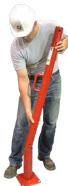
Nosturin masto työnnetään työmaalla yksinkertaisesti olemassa olevaan mastokannattimeen (pohja ...).
